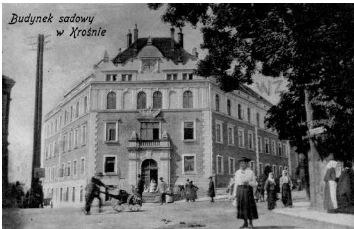
Il.1. Budynek C.K. Sądu Powiatowego w Krośnie z roku 1914. Na fasadzie budynku zegar z Fabryki Zegarów M. Mięśowicza w Krośnie i orzeł austriacki.
